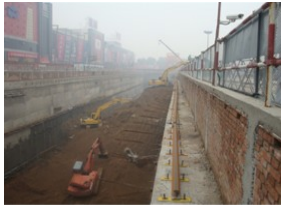
图 1-4 锚索基坑土方开挖
