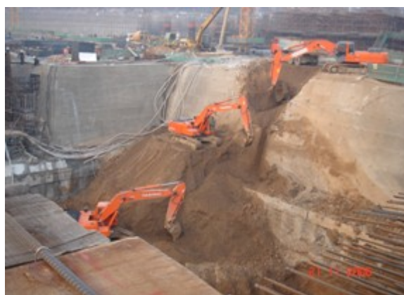
图 1-2 深基坑分层放坡开挖
