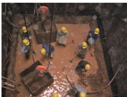
图 4-4 井壁倒挂格栅开挖竖井
