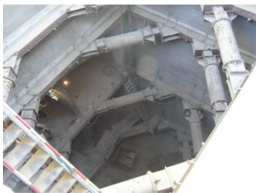
图 4-3 桩+钢支撑风井
