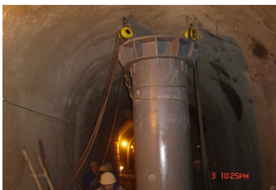
图 6-2 洞内孔桩混凝土浇筑
