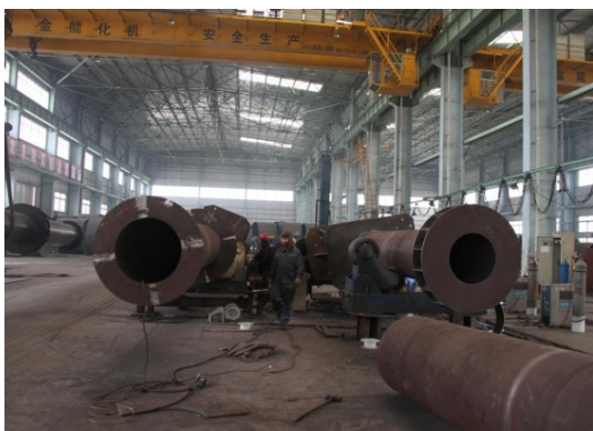
图 6-1 钢管柱工厂制作
