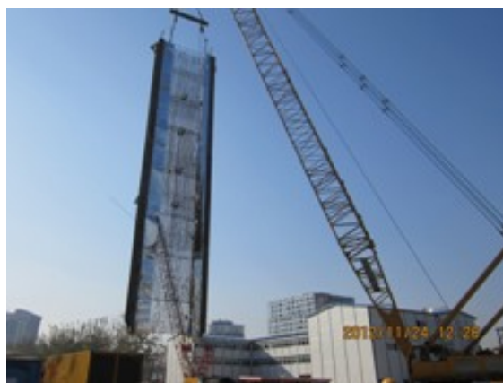
图 2-2 连续墙钢筋笼吊装
