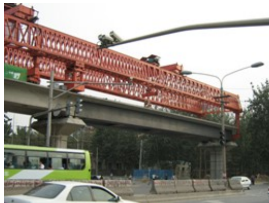
图 4-2 架桥机架梁
