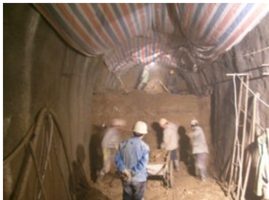
图 1-5 暗挖土方和淤泥
