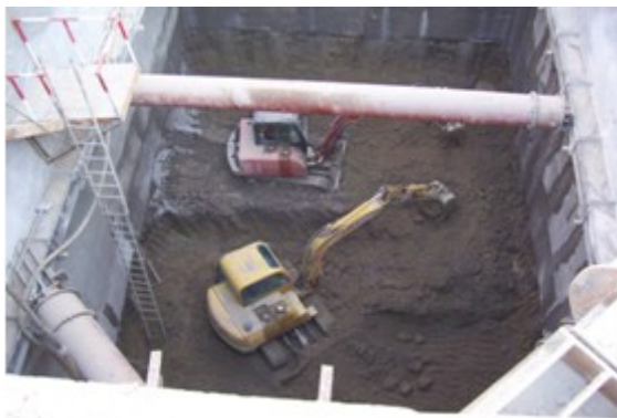
图 1-8 盾构井土方机械开挖
