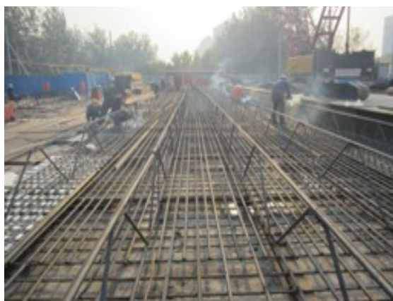
图 2-1 连续墙钢筋制作
