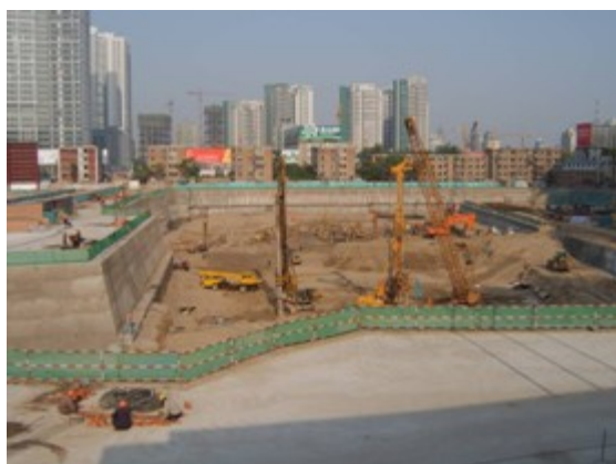
图 1-1 浅基坑直接开挖
