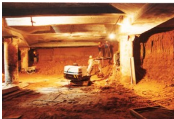
图 1-6 盖挖土方
