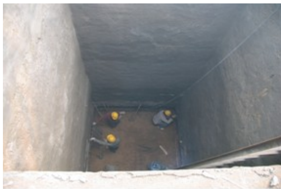
图 1-7 竖井土方人工开挖
